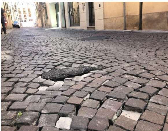
Contra' San Paolo Anche l'arteria del centro storico finirà sotto i ferri con una nuova pavimentazione
